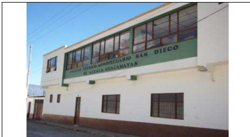
Gráfico 6. Instalaciones de la Institución Educativa Técnica San Diego de Alcalá sede de bachillerato
